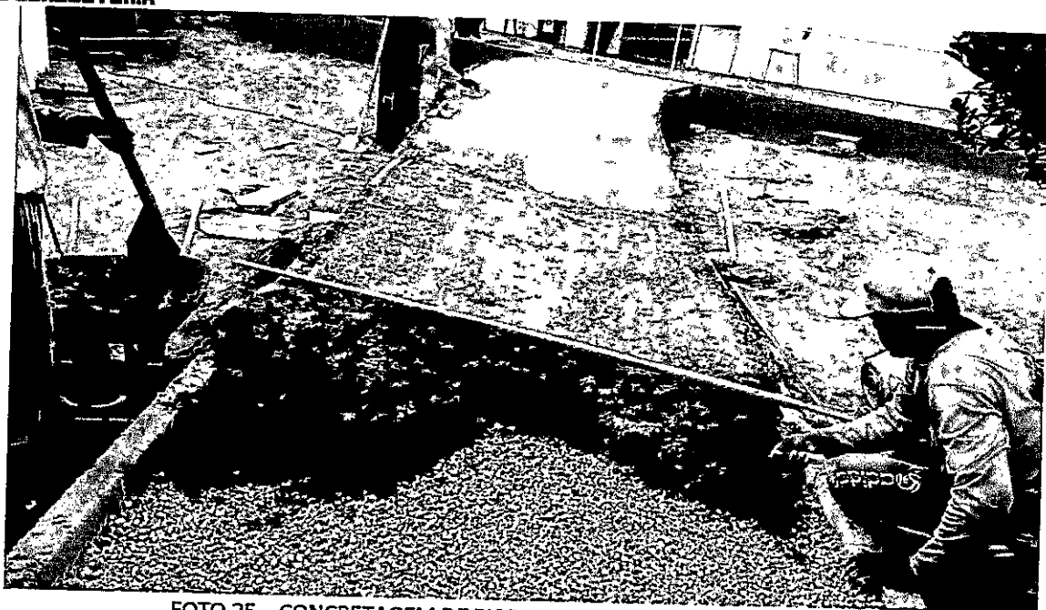
FOTO 25 – CONCRETAGEM DE PISO – ACESSIBILIDADE – FONTE: AUTOR
