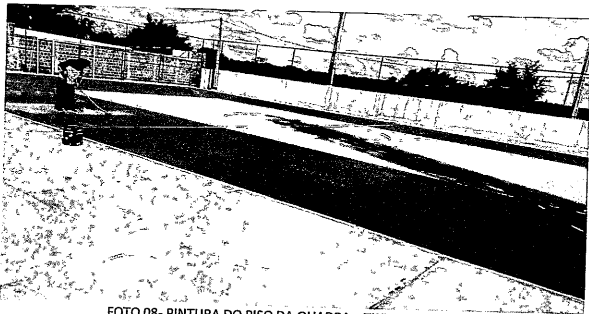
FOTO 08- PINTURA DO PISO DA QUADRA – TINTA ACRILICA
