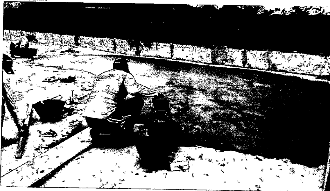
FOTO 07 – CONCRETAGEM DE PISO – QUADRA – FONTE:AUTOR
