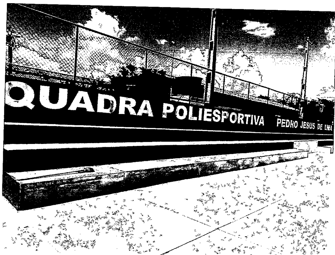
FOTO 19 – PINTURA ARQUIBANCADA E LETREIRO + ALAMBRADO PINTADO
