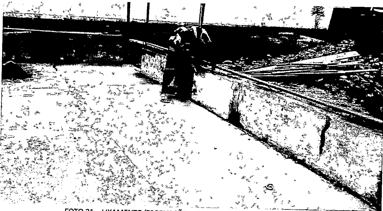
FOTO 31 – LIXAMENTO/ESCOVAÇÃO – MURETA – PARTE INTERNA – FONTE:AUTOR
