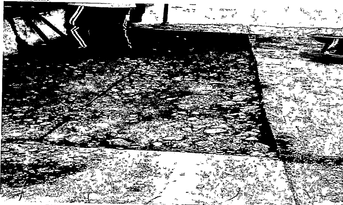
FOTO 03 – DEMOLIÇÃO MANUAL DE PISO – QUADRA – FONTE:AUTOR
