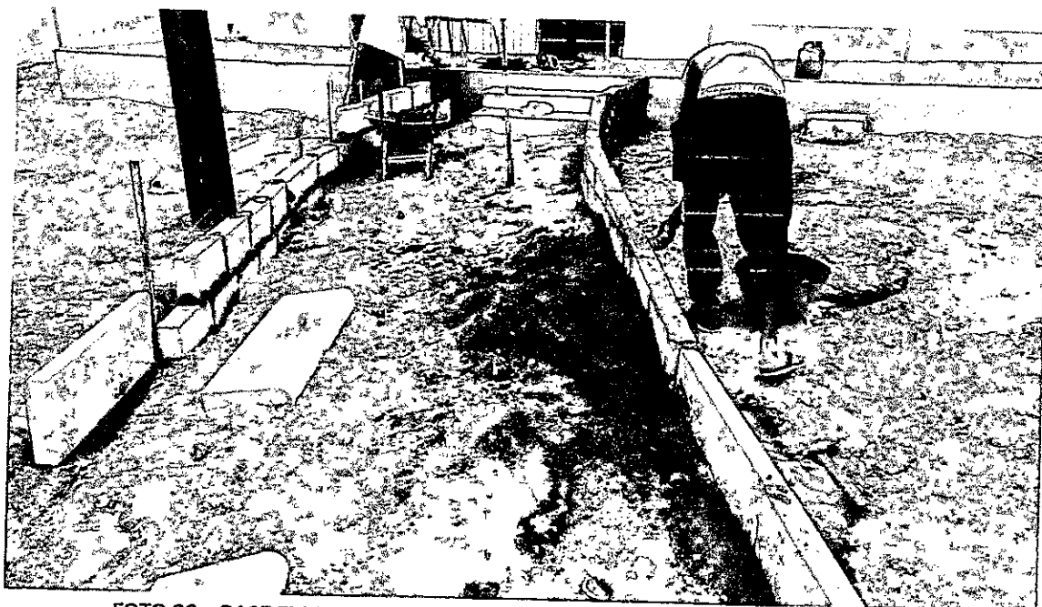
FOTO 23 – BASE EM BLOCO DE CONCRETO E GUIA DE CONCRETO – FONTE: AUTOR
