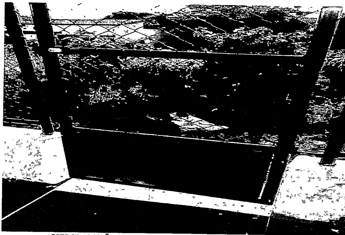
FOTO 30 – PORTÃO LATERAL INSTALADO – LADO ESCOLA – FONTE:AUTOR
